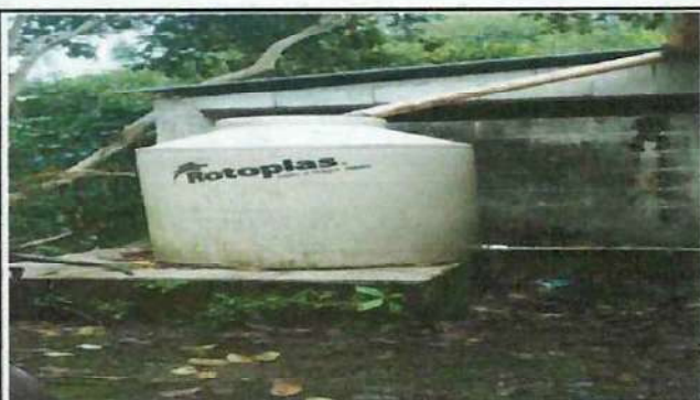
Foto 5: Sustitución de depósito de agua.
