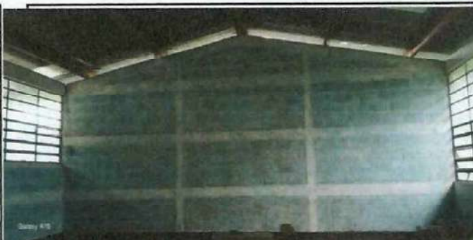
Foto 6: deterioro de pintura y faltantes de pinturas en algunas partes de la pared.
